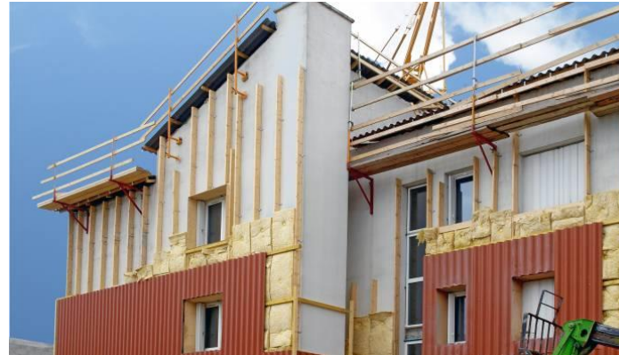
Renforcement de l'isolement acoustique des façades
