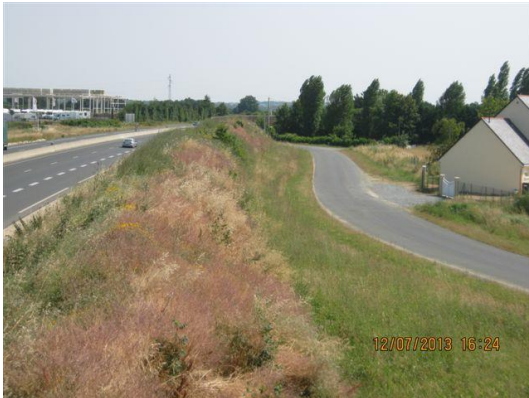
Merlon acoustique (RD775)
